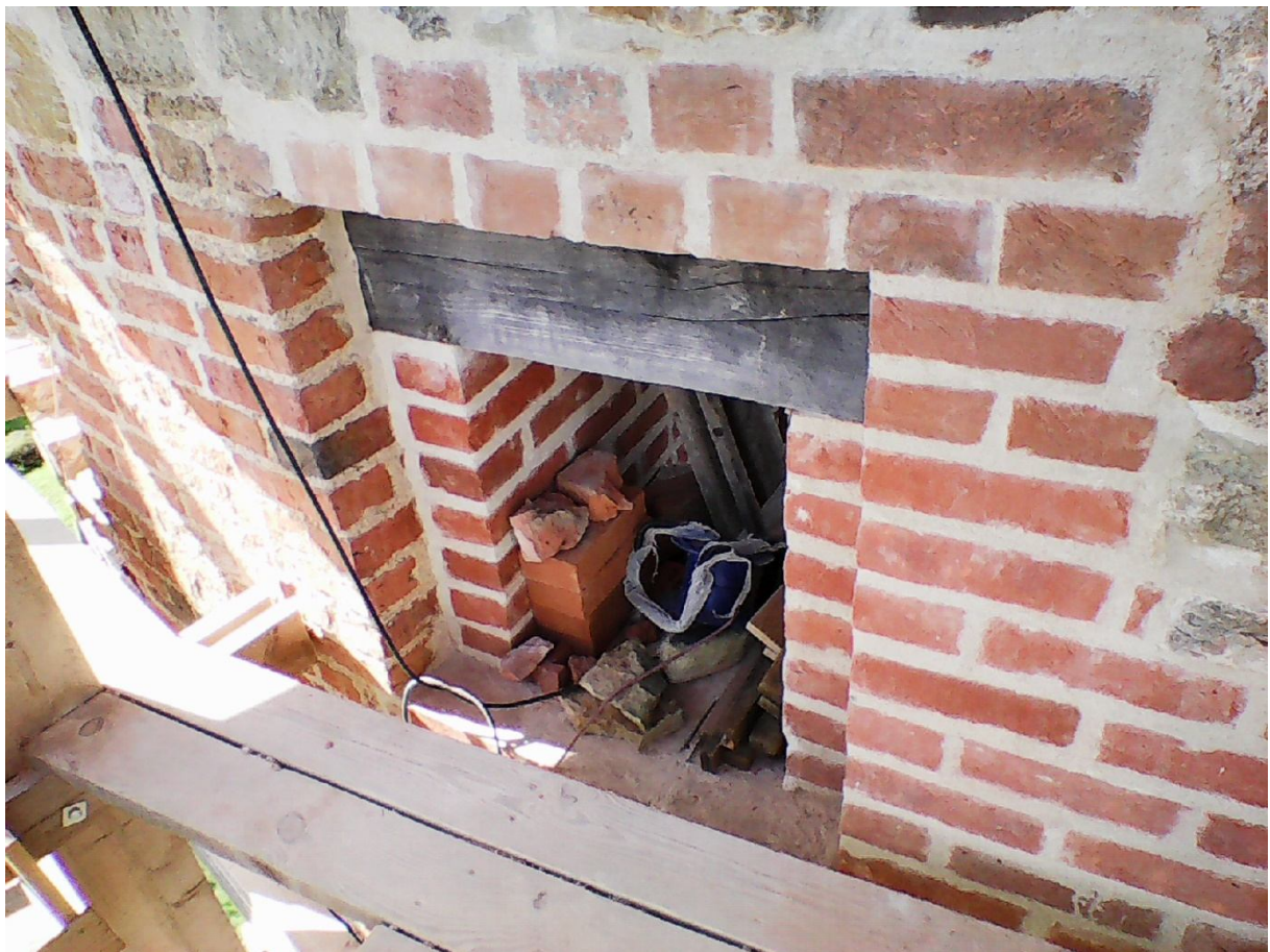
11. Laskekamber pärast taastamist. Vaade torni välisküljest (08.2019)
