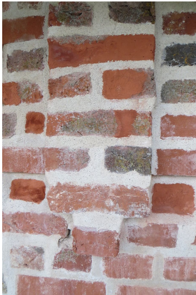
19. Konserveeritud rippliseen. Näha Remmersi tellise- parandusseguga parandatud telliseid (07.2019)
