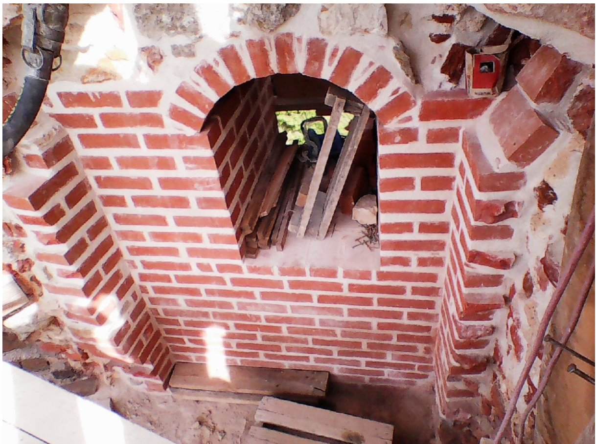
12. Laskekamber pärast taastamist. Vaade torni siseküljest (08.2019)
