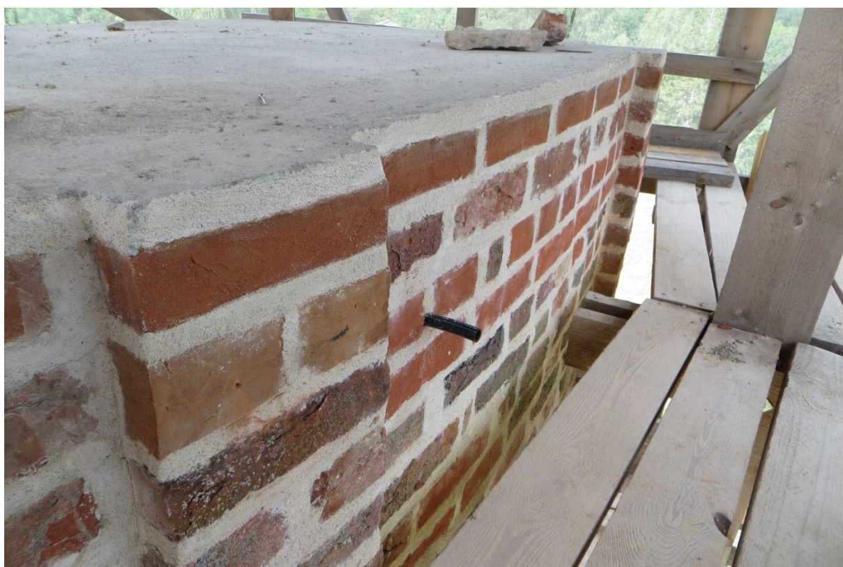
16. Konserveeritud (osaliselt taastatud) müürilõigu ülemine osa koos rippliseenidega (07.2019)
