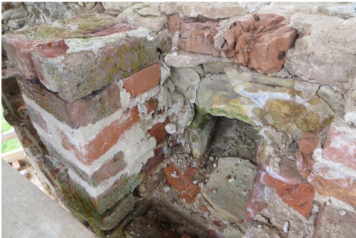
5. Rippliseeni ülemine osa ja sellega külgnev lagunenud seiniosa konserveerimise alguses (06.2019)
