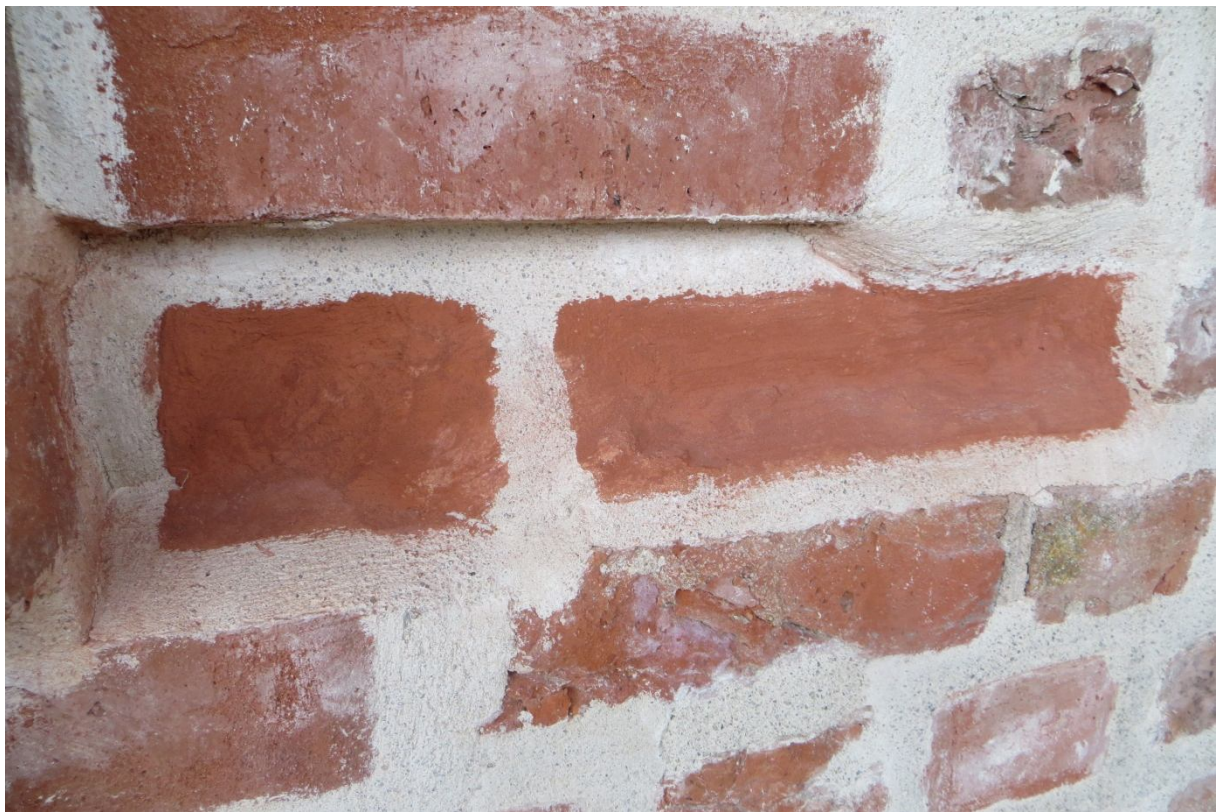
17. Konserveeritud müür lähivaates. Korralikult teostatud vuukimistöö ja telliste parandamine (07.2019)
